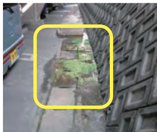
湧水部分にコケが生えている擁壁
