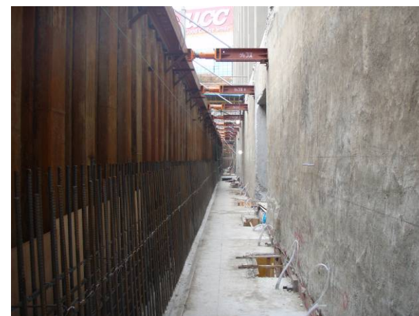
免震ドライエリア杭打設 平成19年7～8月
