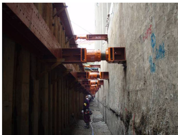
外周部掘削工事（手順1） 平成19年9～11月
