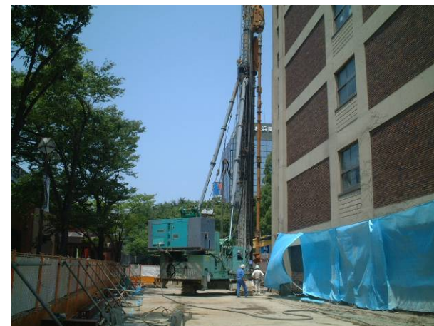
免震ドライエリア杭打設 平成19年7～8月
