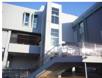
新設エレベーター (15人乗、シースルー)
