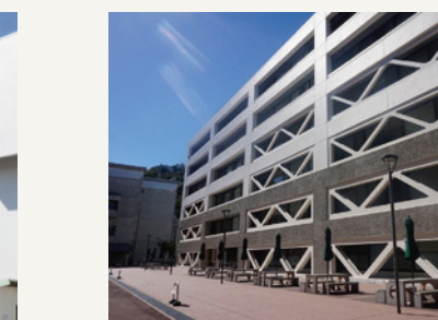
横浜市立大学金沢八景キャンパス文科系研究棟耐震改修
