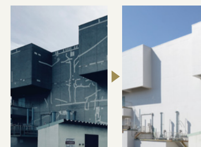
樽町ポンプ場外壁改修
