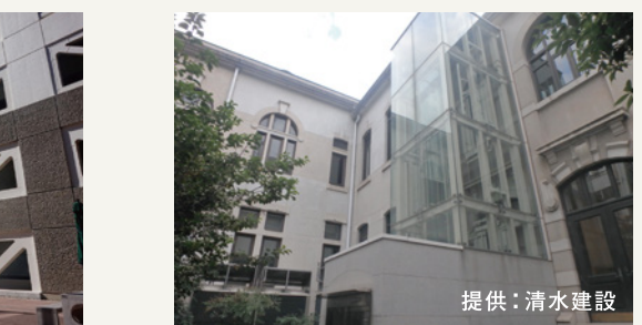
開港記念会館エレベーター設置
