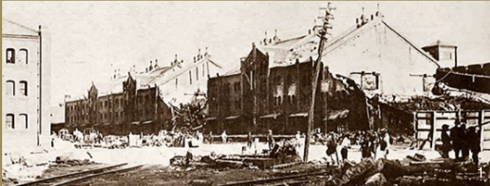
1:1923 赤レンガ倉庫(1号館)〈横浜都市発展記念館所蔵〉被災した1号館
