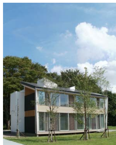
LCCM 住宅デモンストレーション棟
