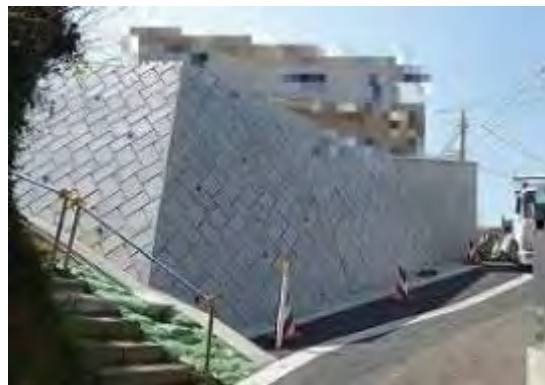
改善後（間知ブロック石積擁壁）
