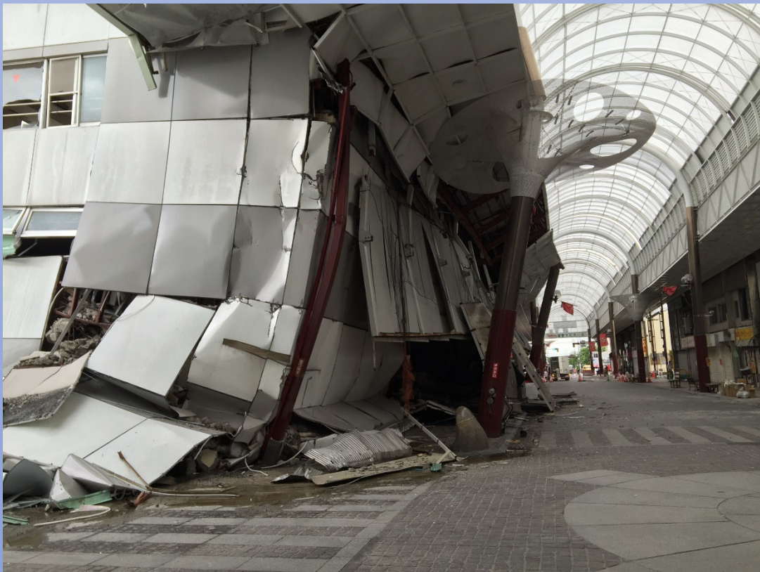
熊本地震にて倒壊した建築物(熊本市)
