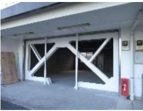
マンションの1階に耐震補強をした事例
