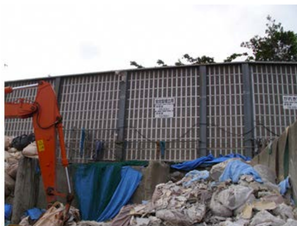
処分場の確認
