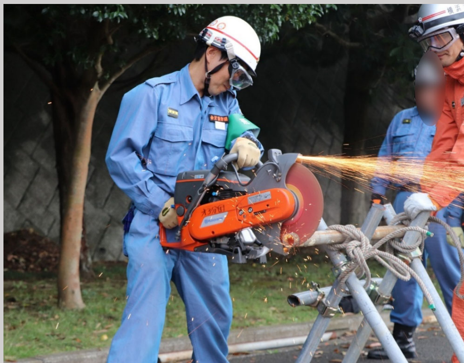
資機材取扱訓練(10月)
