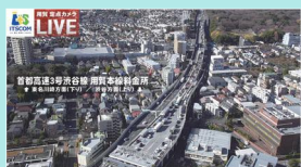
首都高速3号渋谷線 用賀本線料金所
