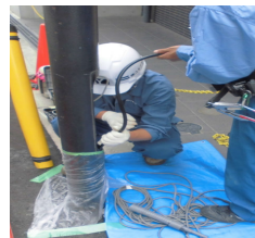
③ 支柱内残置物の撤去
