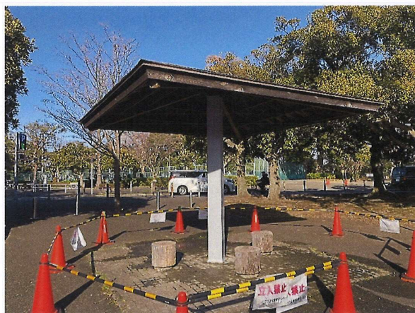
全景(補強完了)
