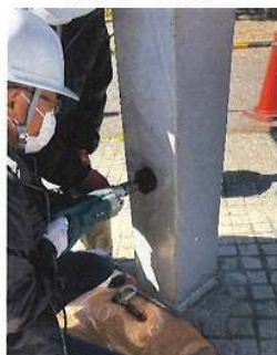
（注入口 削孔）
