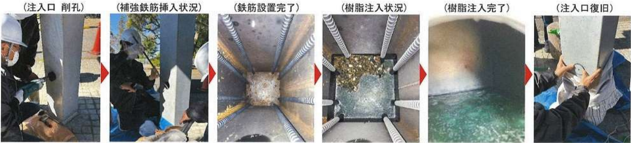
鋼管の樹脂コンクリート注入補強工法の施工方法
