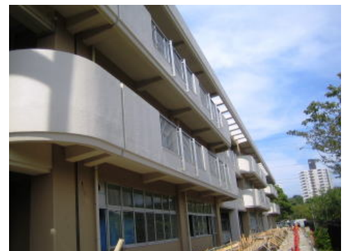
改装中の校舎（7月）〈市HPから〉
