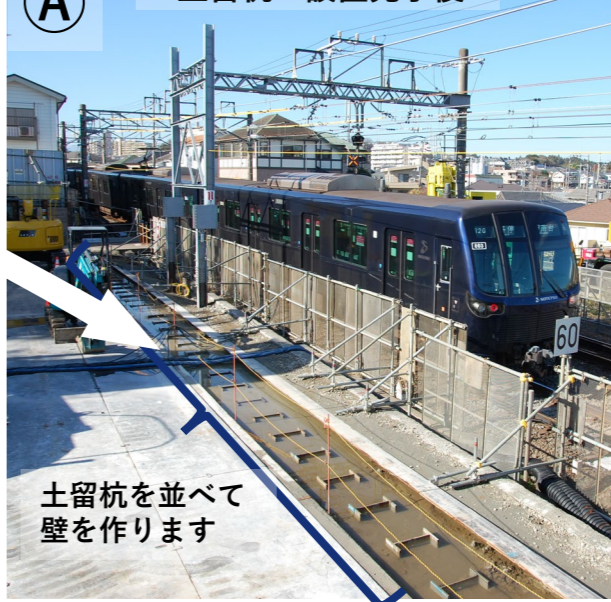
<土留杭の設置完了後>
