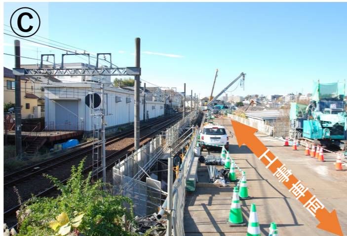
線路脇の斜面地を活用し、ヤード②までの工事車両専用の通路を設けました。工事車両が生活道路を通行することを極力減らしています。
