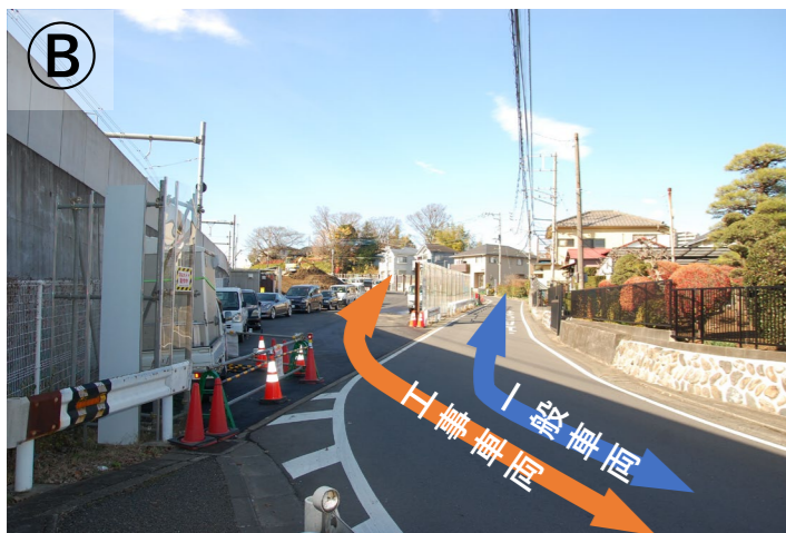
工事車両が一般車両の通行を妨げないよう、ヤード①を工事車両の通行路や待機場として整備しています。
