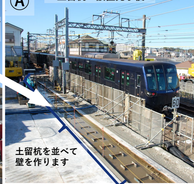
<土留杭の設置完了後>
