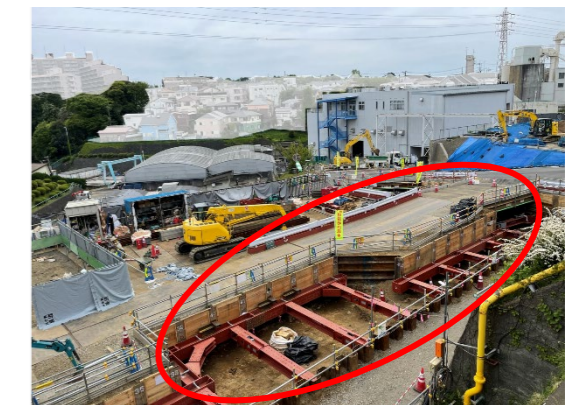
写真2 排水処理施設の工事状況
