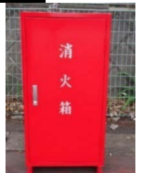
スタンドパイプ式初期消火器具(可搬式) 初期消火箱(固定式)
