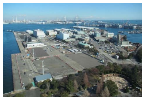
更地化の状況（令和2年1月）
