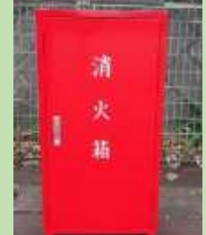
初期消火箱（固定式）
