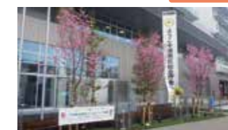
区庁舎の緑化(港南区)
