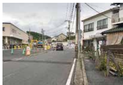
▲白根通り拡幅工事
