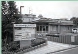
さつきが丘地域ケアプラザ
