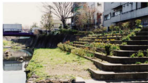
階段型の護岸で水辺へ近づけます (阿久和川かもめ橋付近)
