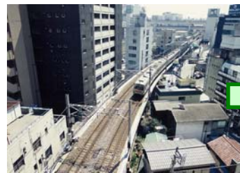
高島山トンネル付近（横浜駅側）の様子
