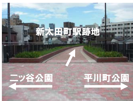
トンネル上部の緑道
