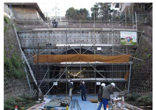
高島山トンネル補修工事实施状況
