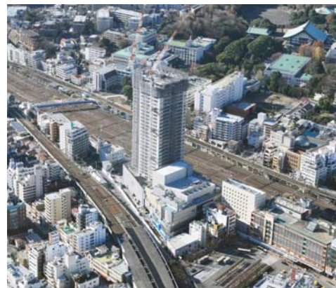
工事進捗写真(平成21年12月時点)
