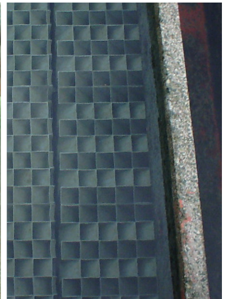
遮光板設置後の沈でん池の状態
