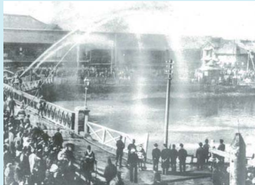
明治 20 年に工事が完了して、吉田橋(中区)で行われた消防出初式の様子
