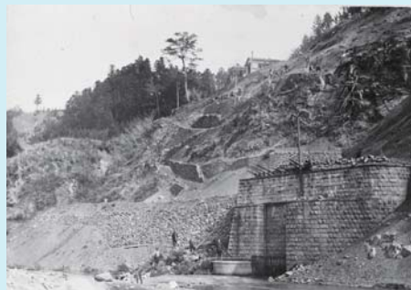
関東大震災で被害を受けた鮎子取水せき
