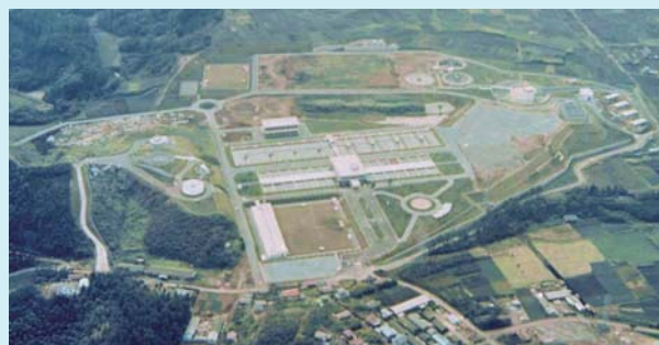
第 6 回拡張工事で築造された小雀浄水場 (昭和 39 年完成)
