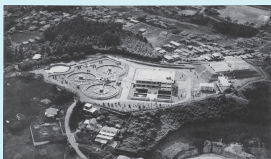
昭和 36 年頃の鶴ヶ峰浄水場 (現在は廃止、配水池として築造中)
