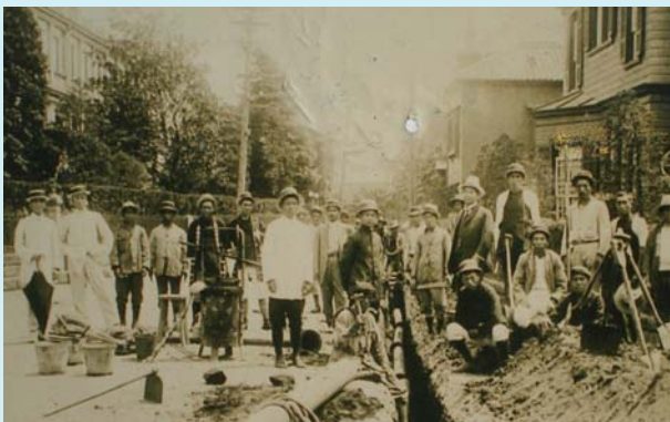
山手で行われた配水管工事の様子(明治 30 年頃)
