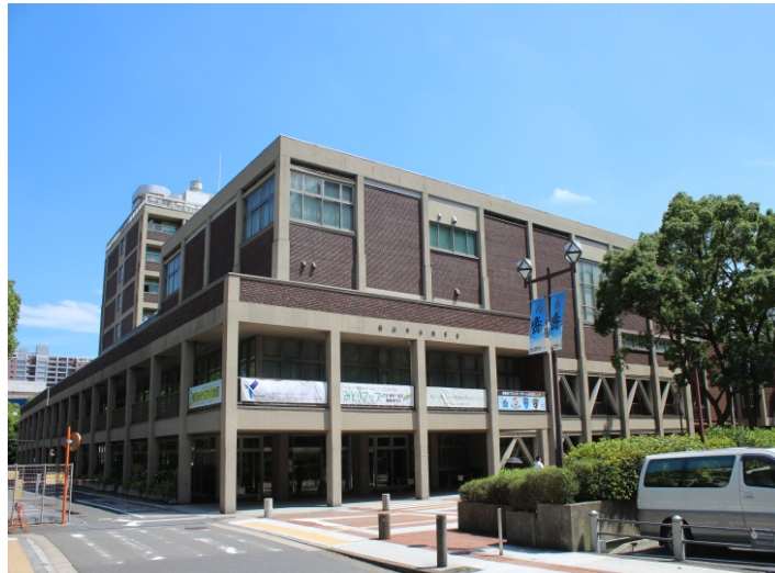
Edificio del Concejo Deliberante de la Ciudad de Yokohama
