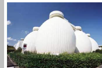
下水汚泥消化施設 (北部下水道センター)
