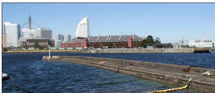
以港口地区为背景的象鼻地区(防波堤附近)
