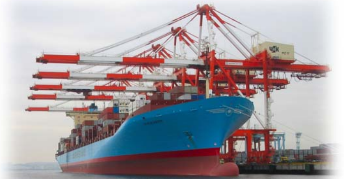
可操纵22排箱子的超大型桥吊和大型集装箱货轮
