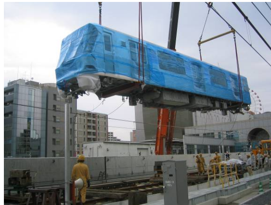
車両搬入（センター北駅）
