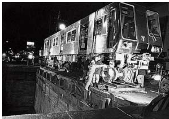
車両搬入（組立中）
