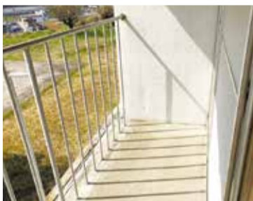
部材を細くし、室内からの開放感を邪魔しない手すり
