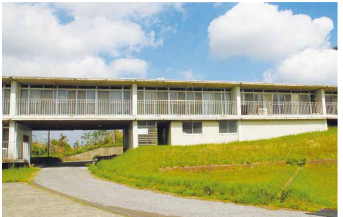
部材を細くし、室内からの開放感を邪魔しない手すり
