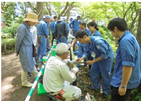
◆本市職員も竹垣の施工に参加しました
