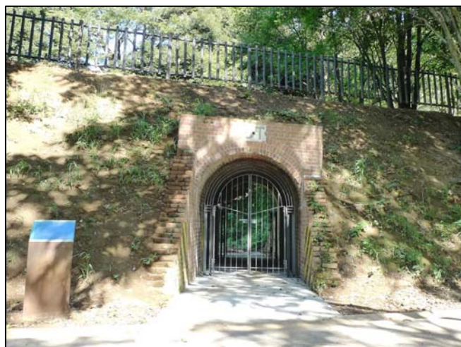
【レンガ造りのトンネル遺構】
