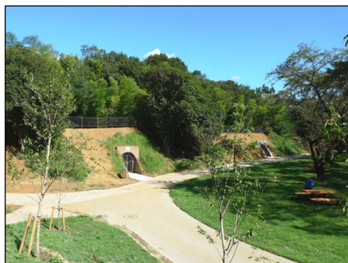
【保存土塁とトンネル】
