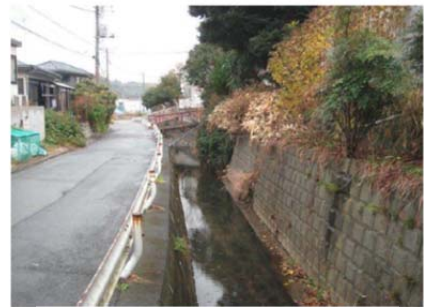
大面川雨水幹線現況写真
