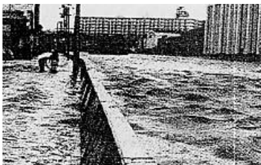
昭和54年10月19日、台風20号による被災状況
