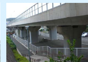
高架下の利用 (長沼大橋(栄区))
