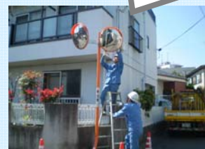
カーブミラー補修の様子
