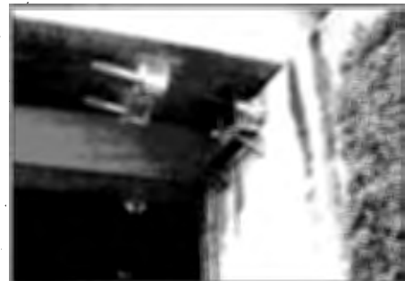
PC鋼棒で連結し、落橋防止を施した橋 (清水ヶ丘公園東橋・南区)
