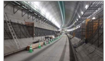
整備中の横浜環状北西線
