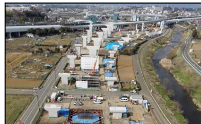
整備中の横浜環状北西線
