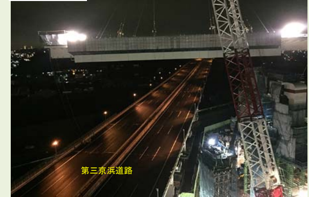
⑩横浜港北JCT付近上部工架設(H29.10.14第三京浜通行止め) ※首都高施工区間
