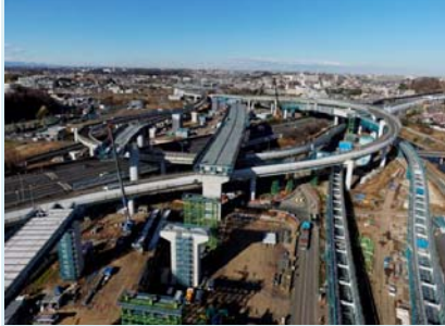
②横浜青葉IC・JCT付近の架設状況
