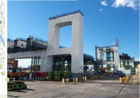
⑩横浜港北JCT付近上部工架設(H29.10.14第三京浜通行止め) ※首都高施工区間
