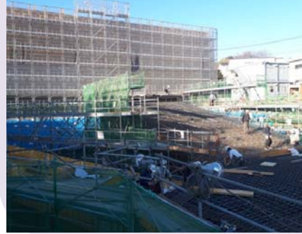
⑦(仮称)東方換気所
