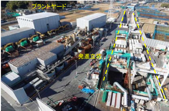
④全景（プラントヤード・発進立坑）
