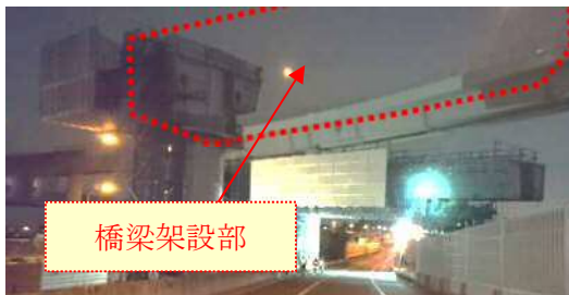
①架設前【H29.6 横浜青葉 IC D ランプ閉鎖時】
