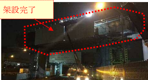
③架設後【H29.6 横浜青葉 IC D ランプ閉鎖時】
