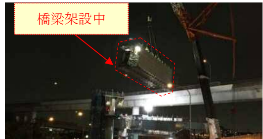
②架設中【H29.6 横浜青葉 IC D ランプ閉鎖時】
